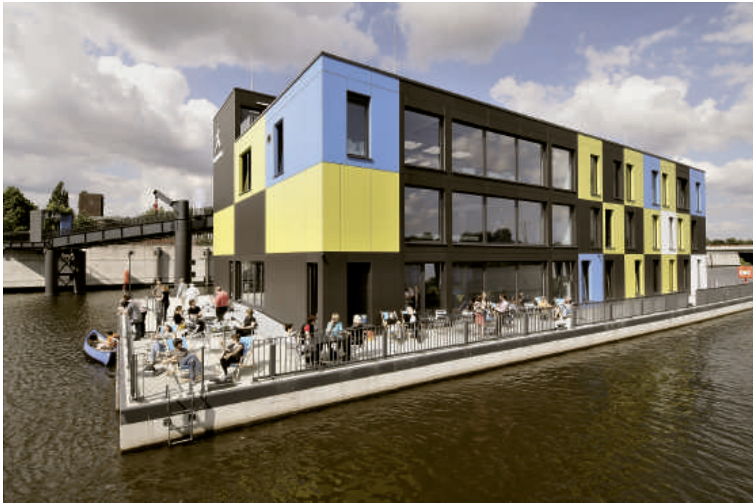
Schwimmendes Ausstellungsgebäude: Entspannen auf der Terrasse des IBA-Docks im Müggenburger Zollhafen von Wilhelmsburg
